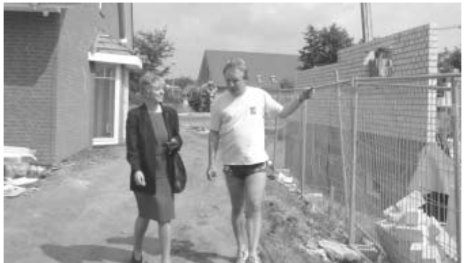
Bauherr Joachim Becker erläutert Bürgermeisterin Ursula Pepper den Baufortschritt bei den Ein- und Mehrfamilienhäusern im Ludwigstrüing
